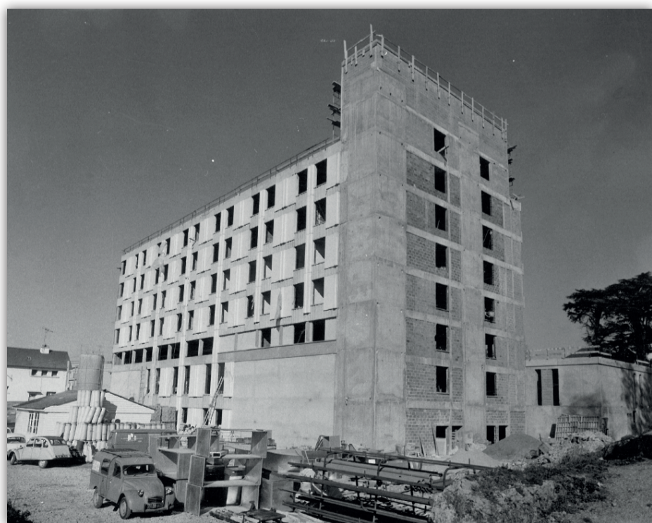
Construction du nouvel hôpital
